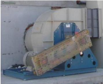
L'impianto di aspirazione, oltre che dalle cappe già precedentemente descritte disposte sulle singole vasche, è corredato da aspiratori di potenza e caratteristiche adeguate e da collettori colleganti le cappe agli aspiratori.
