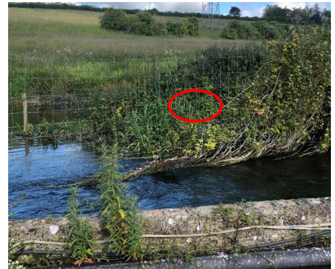
Outlet 1b: D block effluent
