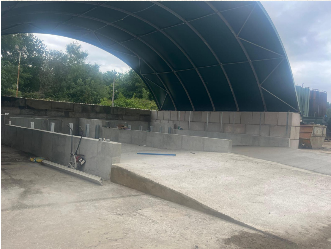
Image 5 – Bay D12 – Right of Image, D13 Left of Image, Image 6 – Bay D13 foreground, D12 background
